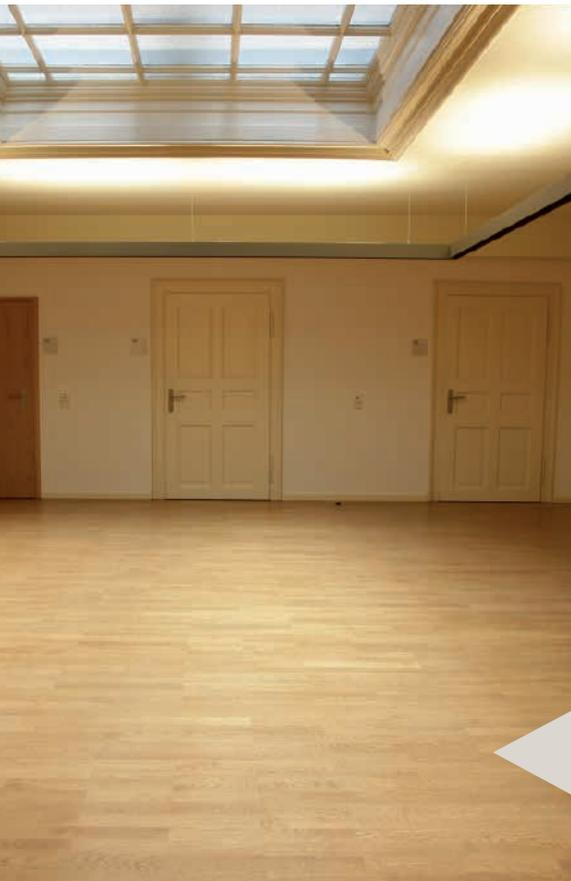
Stabparkett besteht aus einzelnen massiven Holzstücken mit einer bis zu 10 Millimeter starken Nuttschicht. Es kann oft nachgeschliffen werden und ist praktisch unverwüstlich. Die Stäbe können in allen Varianten verlegt werden – als Fischgrät- oder Würfelmuster, im Parallelverband oder geflochten. Wir richten uns da ganz nach Ihren Wünschen!
