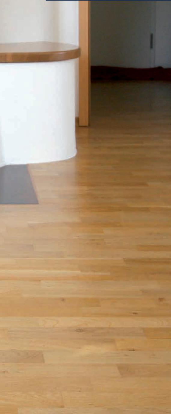
Optisch ist das Massivholz-Lamparkett der kleine Bruder des Stabparketts. Es ist in Länge und Breite eingeschränkt und nur zehn Millimeter stark ohne Nut- und Federverbindung. Von der geringen Konstruktionshöhe der Stäbe profitieren Sie, wenn auf vorhandenem Estrich ohne großen technischen Aufwand ein Parkettboden verlegt werden soll. Und dennoch ist die Nutzschicht dick genug, um auch mehrmaliges Renovieren problemlos zu ermöglichen.
