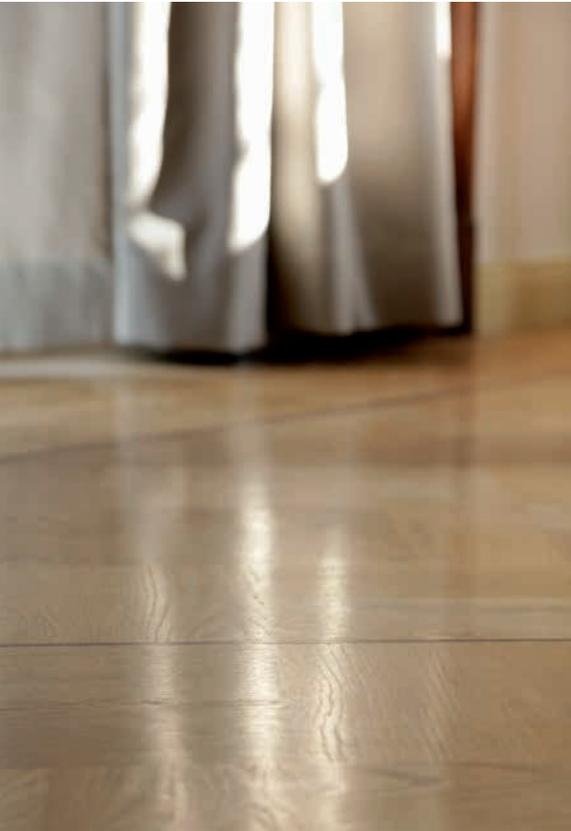
Mosaikparkett ist ein vollwertiger Massivboden aus dünneren Holzlamellen, die auf Netz geklebt und dann verlegt werden. Das spart Arbeitszeit und Kosten. Die geringe Lamellenstärke sorgt für maximale Ausnutzung des Materials. Sie ist auch von Vorteil, wenn Parkett einen anderen Bodenbelag ersetzen oder die Wärme einer Fußbodenheizung möglichst ungehindert strömen soll.
